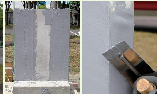
写真・14 タイルアジャスト施工完了
