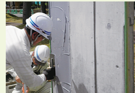
写真・12 タイルアジャスト施工アップ
