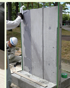
写真・11 タイルアジャスト施工
