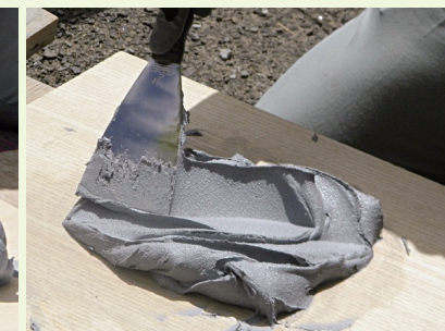
写真・10 タイルアジャスト混練
