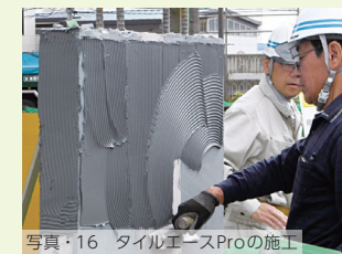
写真・16 タイルエースProの施工
