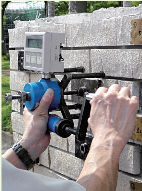
写真・27 引張強度試験(二丁掛タイル)
