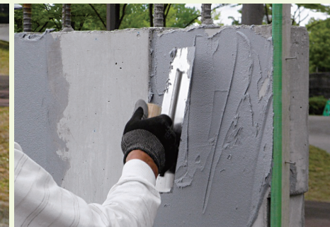
写真・13 タイルアジャスト施工アップ
