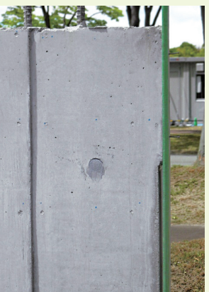
写真・6 欠き込み部
