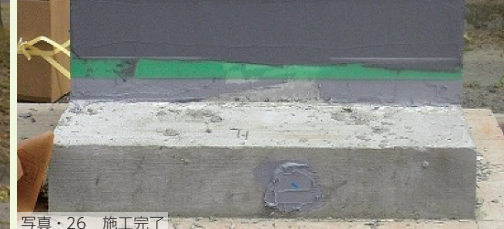
写真・26 施工完了
