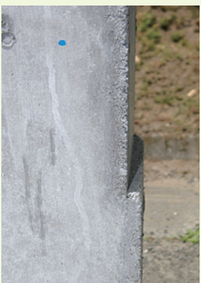
写真・7 欠き込み部アップ
