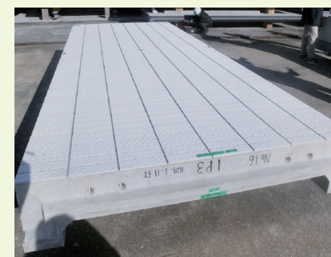
写真・8 表面仕上りの状況(全景)
