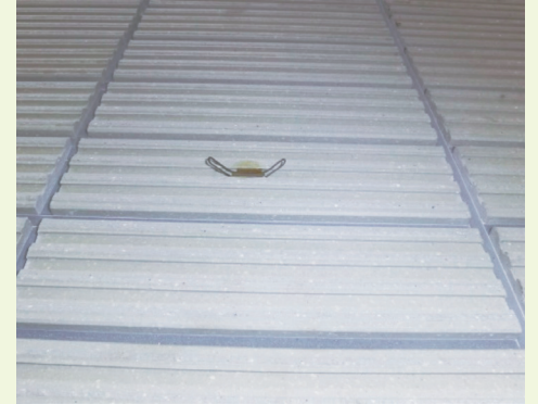
写真・4 脱落防止金物の取付3
