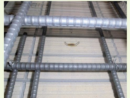
写真・7 配筋した状況のアップ
