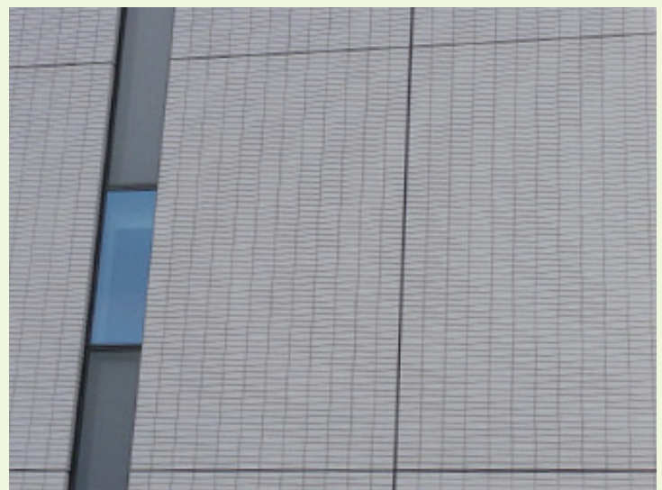
写真・16 PC カーテンウォールの取り付け状況のアップ
