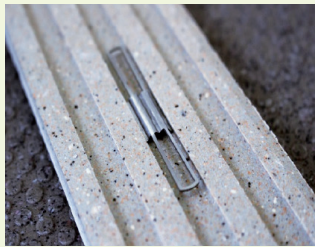
写真・12 脱落防止金物のセット
