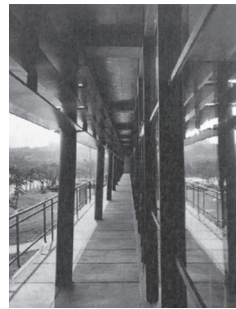
図5 南面2階バルコニーの斜柱 (出典:『新建築』1951年9月)
