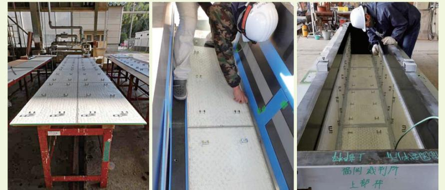
写真・5 クランプセットの状況 写真・6 型枠へのセット 写真・7 シール材の施工
