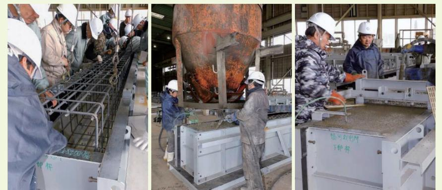
写真・8 鉄筋のセット 写真・9 コンクリート打設 写真・10 こて押し
