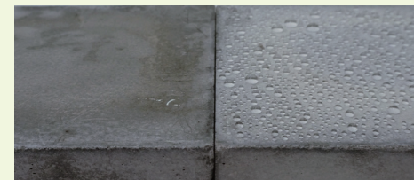
写真・10 効果(左:未施工・右:施工済)
