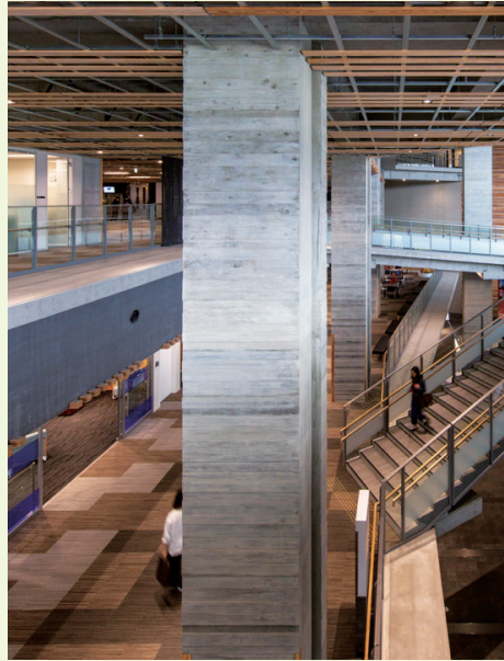
写真・1 長崎県庁舎行政棟の近景(杉板型枠部)
