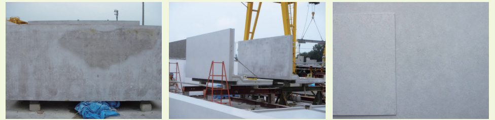
写真・2 施工前のPCの状況
