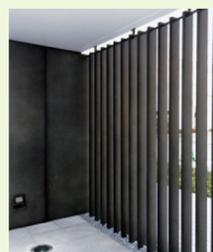
写真・5 リン酸亜鉛処理仕上げ粉体塗装汎用ポリエステル粉体塗装70μ+クリア黒60μ+強制乾燥
