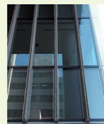
写真・1 高耐候性ポリエステル粉体塗装アルミカーテンウォール
