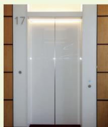
写真・4 鏡面仕上げ粉体塗装汎用ポリエステル粉体塗装100μ+溶剤クリア30μ+強制乾燥
