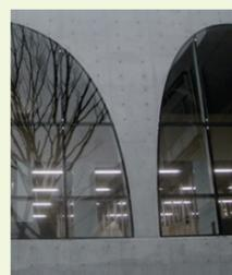
写真・6 下地(目地消し工法)+打放し仕上げ塗装
