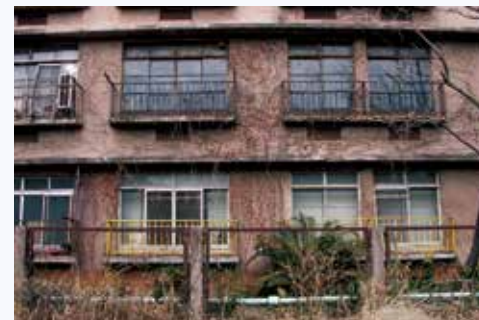
同潤会江戸川アパート解体数年前の写真。小庇はほとんど剥落して、まるでゴーストタウン。手すりが黄色いところに居候していた
