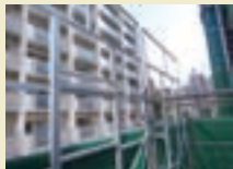
先行手摺工法
