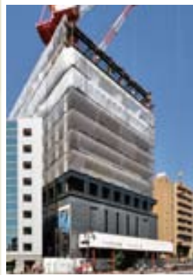
● 麹町1丁目ビル(施工中) 施主 / 住友不動産(株) 施工 / 前田建設工業(株) 内装工事 / 当社
