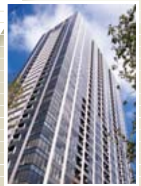
● シティタワー有明 施主 / 住友不動産(株)、住友商事(株) 施工 / 前田建設工業(株) 内装工事 / 当社
