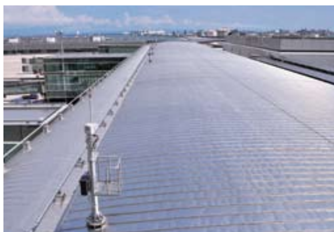
A工区屋根工事(P&Pステンレス防水工法)
