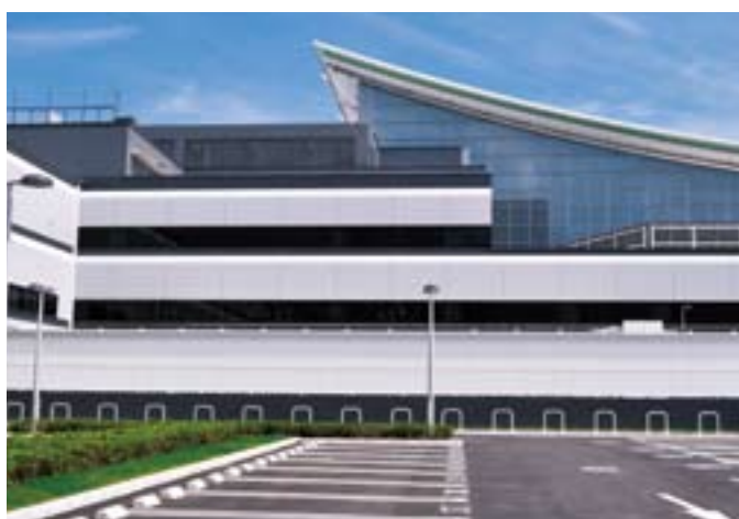
A・B工区外壁工事(耐火エスガード)
