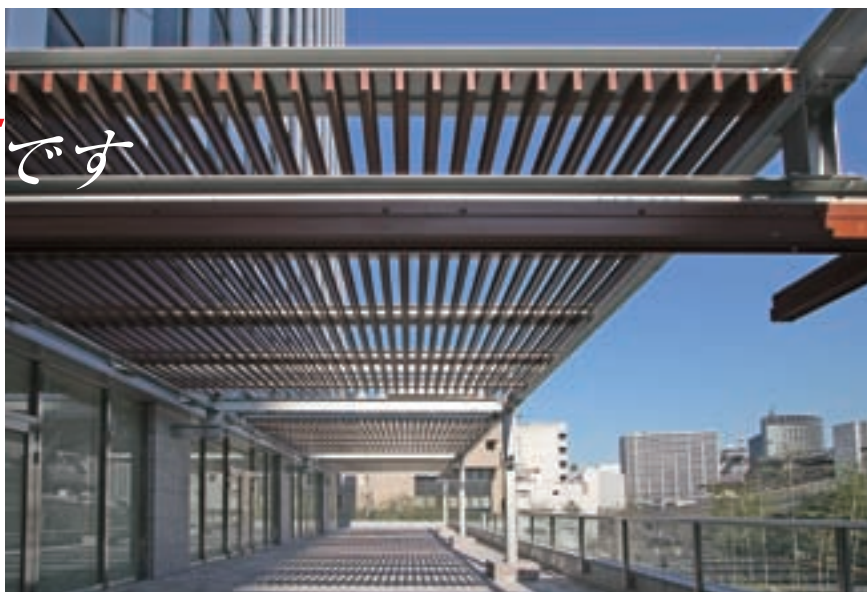
平河町森タワー 【パーゴラルーバー及びガラス手摺】
