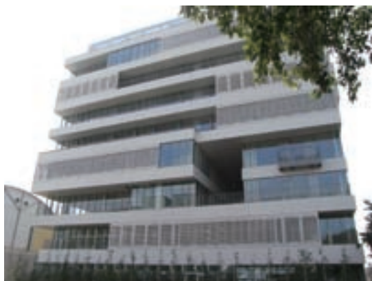
跡見学園女子大学 文京キャンパス2号館 外装GRCパネル
