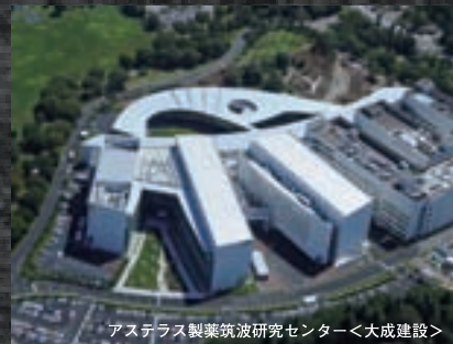
アステラス製薬筑波研究センター<大成建設>
