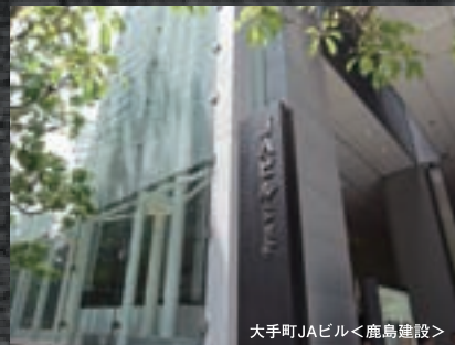
大手町JAビル<鹿島建設>
