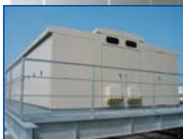
写真：ドーム型受変電設備（実用新案出願中）
