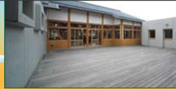
「サニーデッキ」は、超硬質耐朽性デッキ材・ジャラと高耐食性鋼板・タジマジンク（新日鐵製）を加工した根太鋼を組合せ、ノンビス工法によるデッキ材の固定方法を採用した、野外用デッキシステムです。
