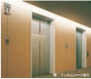
壁：フィルムシート貼り
