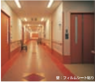
壁：フィルムシート貼り
