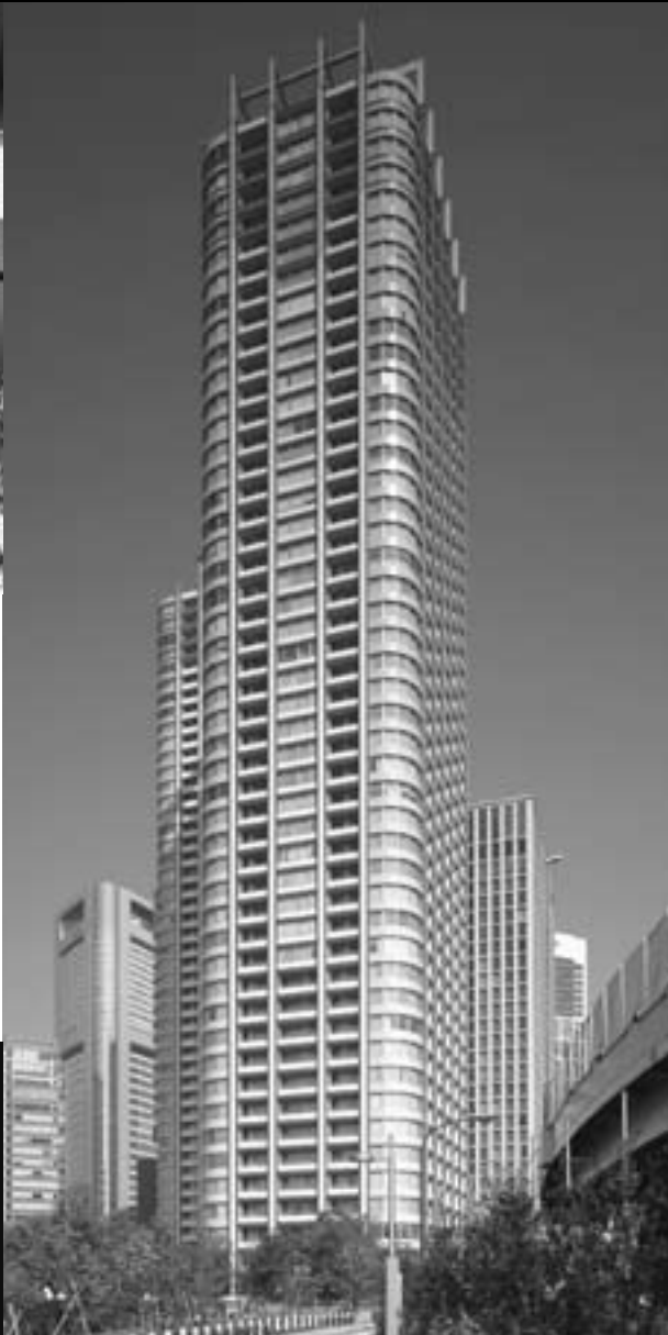
ハイパワーウォールは上下階スラブ間に取付ける非耐力壁のALC外壁です。
