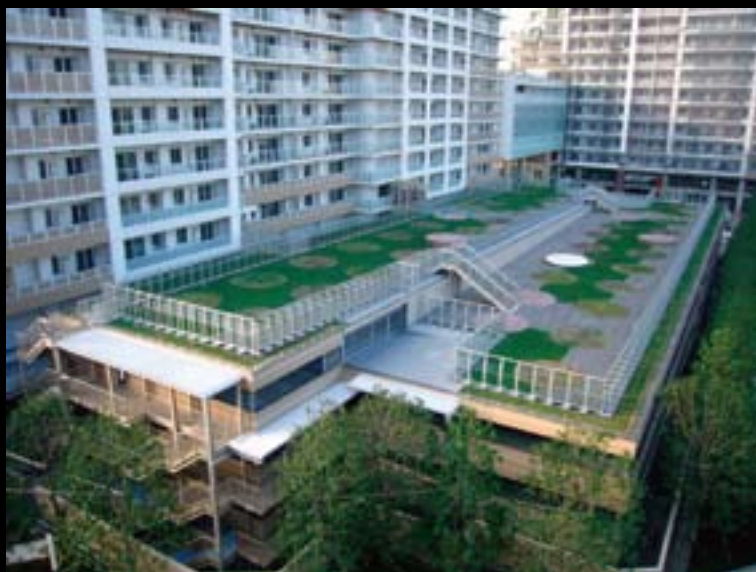
▲簡易型自走式駐車場：パークシティ豊洲 (屋上緑化) ▼建物型自走式駐車場：パースト 24 辛島公園
